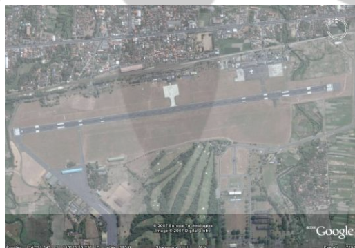
Gambar I.1. Landas Pacu Bandar Udara Internasional Adisutjipto Sumber : Google Earth
