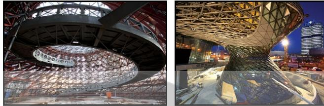
Gambar 5.62 Sistem Space Frame pada BMW Welt, Munich
