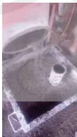
Penuangan Adukan Beton
