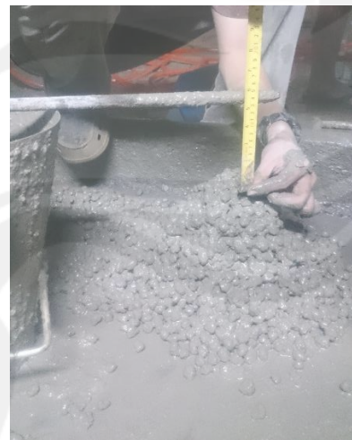
Pengukuran nilai slump
