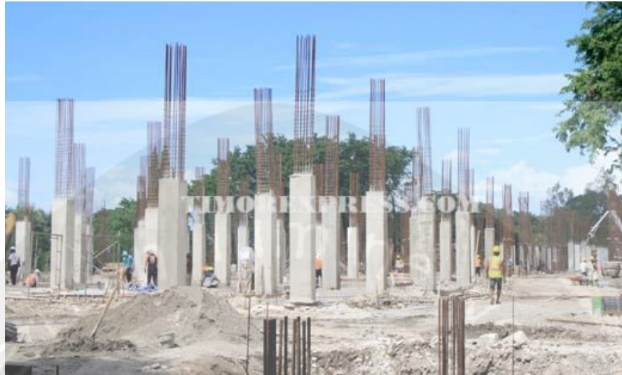
Gambar 1.1 Proyek pembangunan kantor Gubernur NTT yang baru
