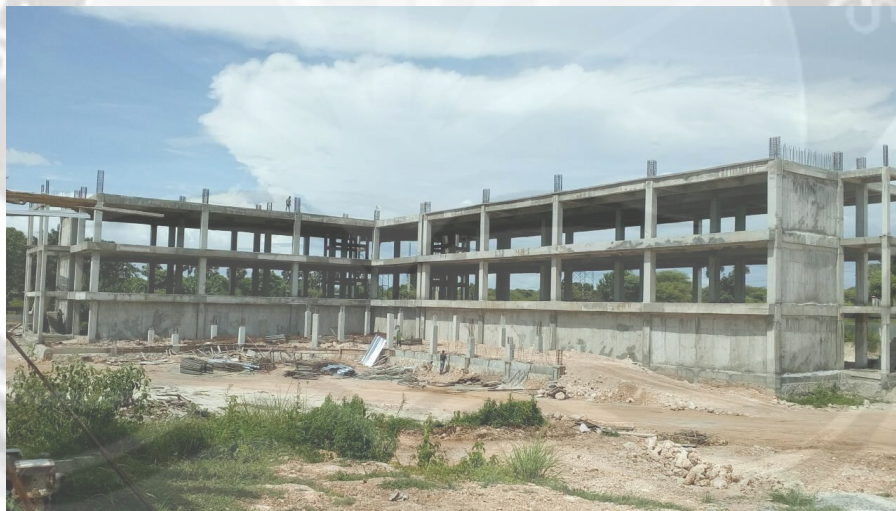
Gambar 1.2 Proyek pembangunan gedung kuliah berlokasi di Politeknik Negeri Kupang
