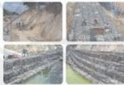
Gambar 5.15. Konstruksi Bronjong pada Tepi Sungai Sumber : Indonesia.blogspot.com (th.2011)
