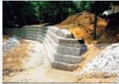
Gambar 5.16. Kontruksi Bronjong pada Tanah Kontur Sumber : Indonesia.blogspot.com (th.2011)
