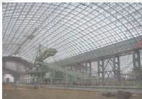
Gambar 6.14 Struktur Space Frame . Sumber: www.google.com/space_frame
