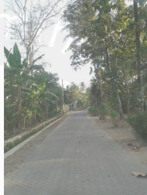
Gambar 3.7. Kondisi jalan utama Desa Wisata Brajan
