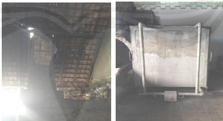
Gambar 2.3 dari kiri ke kanan: Cerobong asap dan tangki solar yang dapat memuat bahan bakar hingga 80 liter
