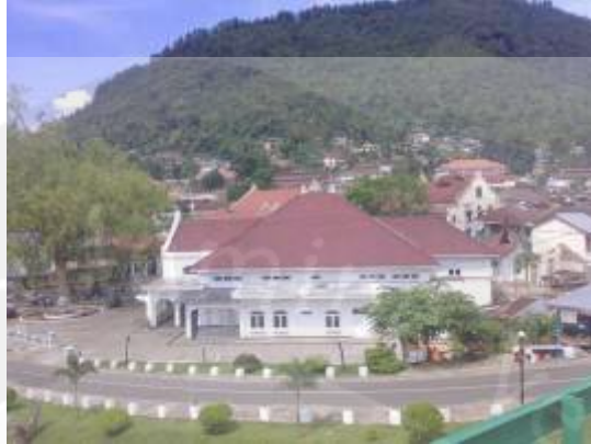
Gambar 2.23 Gedung Pusat Kebudayaan Sawalunto
