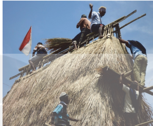
Gambar 14. Penaikan bubungan atap dilakukan oleh penduduk. (Sumber: Dokumentasi Penulis, 2014.)
