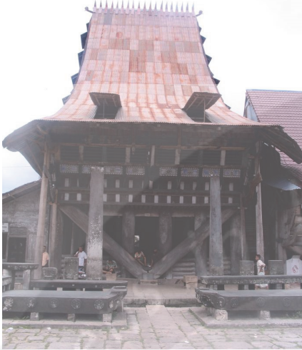
Gambar 1. Rumah Nias, merespon gaya laten akibat gempa dengan struktur V-Shape (Sumber: Dokumentasi penulis, 2010)
