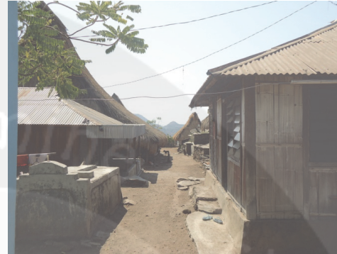
Gambar 6. Penutup atap seng, jendela kaca naco. (Sumber: Dokumentasi Penulis, 2014.)
