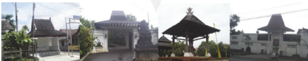
Gambar 8. Penampilan Bangunan Gerbang dan Gardu (Sumber: Peneliti, 2008)
