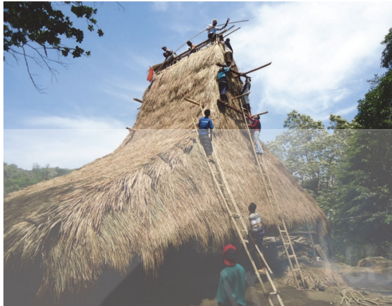
Gambar 13. Penaikan bubungan atap Sao Ria, di Dusun Nua One. (Sumber: Dokumentasi Penulis, 2014.)
