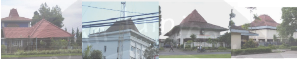
Gambar 4. Penampilan Bangunan Hotel. (Sumber: Peneliti, 2008)
