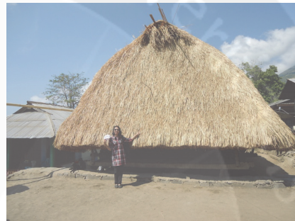
Gambar 2. Tampak depan bangunan vernakular. (Sumber: Dokumentasi Penulis, 2014.)
