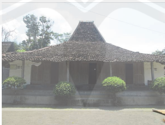
Gambar 3. Kondisi eksisting eksterior joglo 1 (Sumber: Dokumentasi riset 2016)
