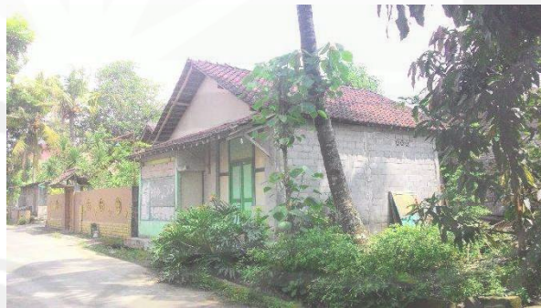
Gambar 6.2-37 : Rumah Eksisting Dusun Pandes Sumber : dokumentasi penulis, April 2016
