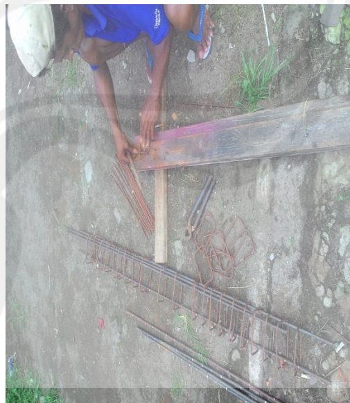
Perangkaian tulangan balok
