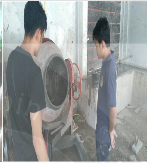
Pencampuran agregat beton
