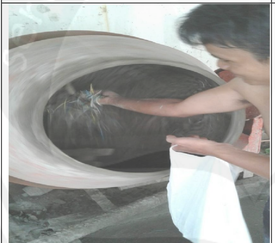
Pencampuran serat ke dalam adukan agregat beton
