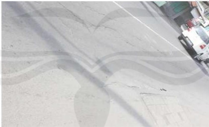
**Gambar 2.18** Penurunan pada Bekas Utilitas (*Utility Cut Depression*)
