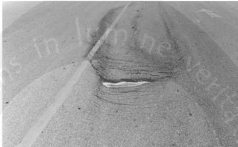
**Gambar 2.7** Retak Selip (*Slippage Cracks*)
