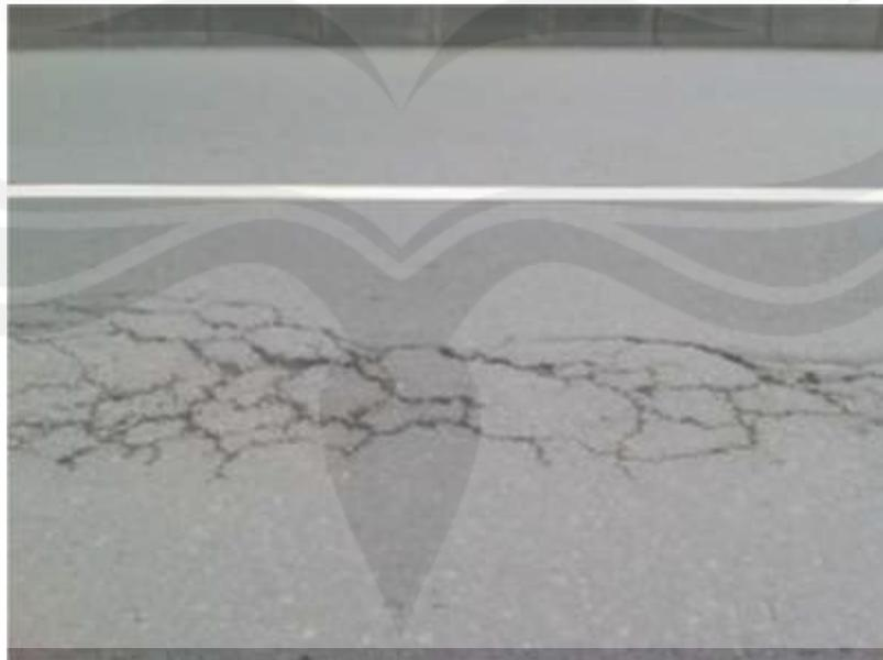
**Gambar 2.3** Retak Kulit Buaya (*Aligator Crack*)
