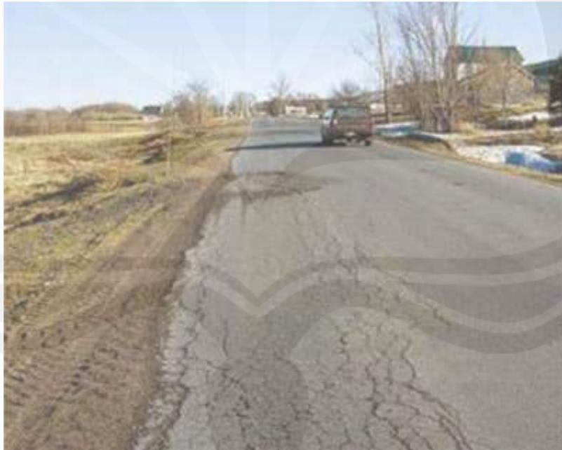
**Gambar 2.4** Retak Pinggir (*Edge Cracks*)
