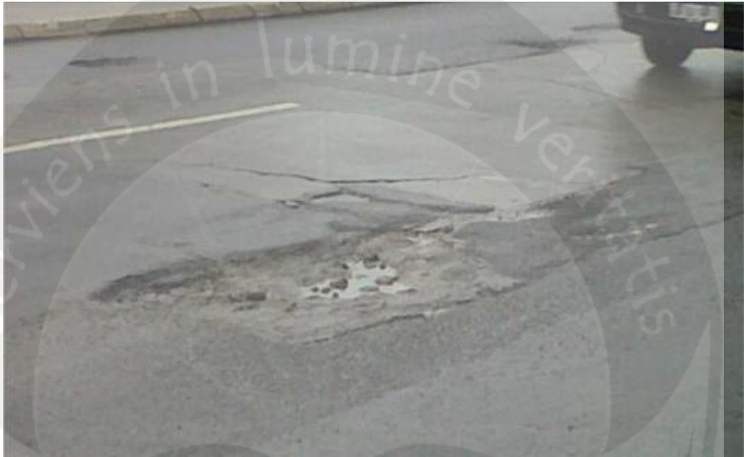
**Gambar 2.15** Pengelupasan Lapisan (*Stripping*)
