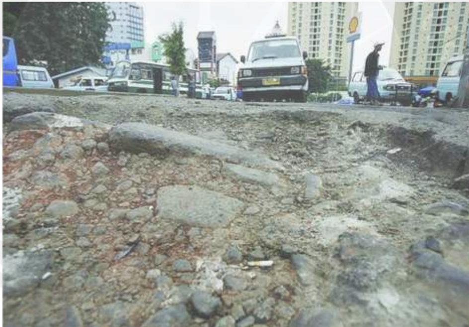
**Gambar 2.14** Pelepasan Butir (*Ravelling*)
