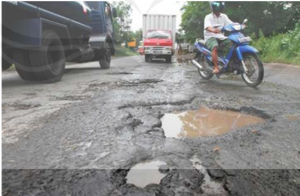
**Gambar 2.13** Lubang (*Pothole*)
