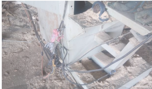
Gambar 4.22 Pengaturan Kabel yang Tidak Rapi
