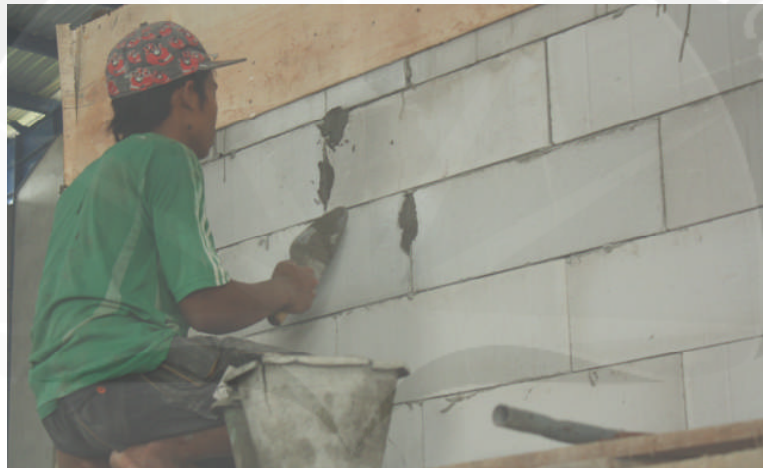
Foto 4 : Effective Work (Memasang bata ringan)
