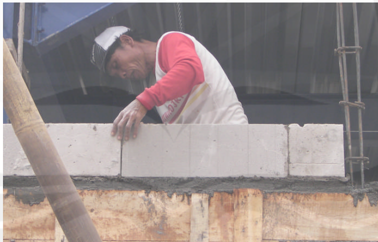
Foto 7 : Memasang Bata Ringan Posisi Sangat Sulit
