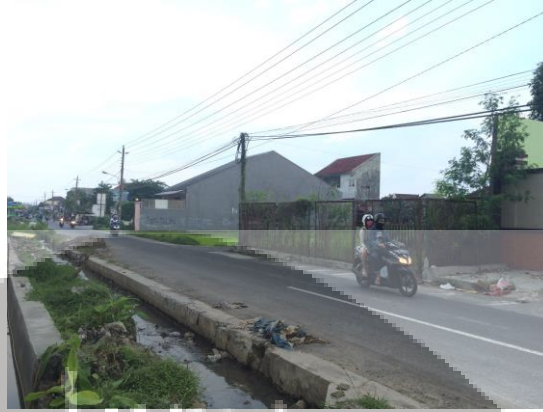
Gambar 3.6 Kondisi Jalan Jambon (depan site)
