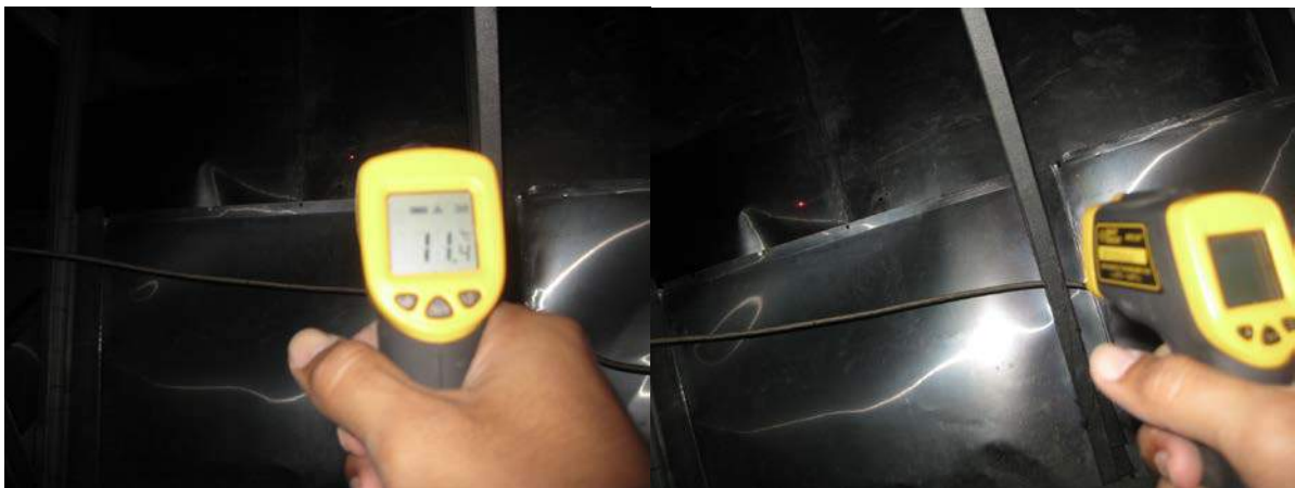
Gambar 9. Proses pengambilan data suhu permukaan plat pada area tertutup (atas plafon)
