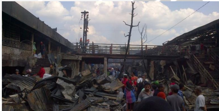
Gambar 1.7 Kondisi Pasar Johar pasca kebakaran Sumber: KOMPAS.com, Sabtu (9/5/2015)
