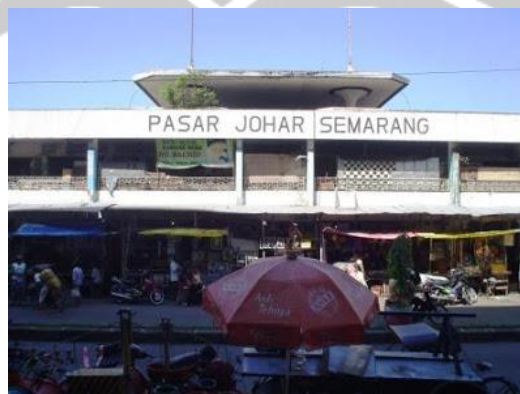
Gambar 1.5 Pasar Johar 2015 sebelum terbakar
