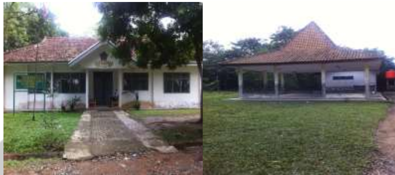
Gambar 1.1. Kondisi Bangunan Fasilitas Penunjang di Pusat Konservasi Gajah
