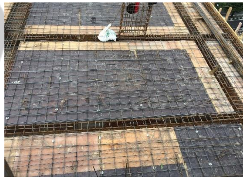
4. Pemasangan Cakar Ayam
