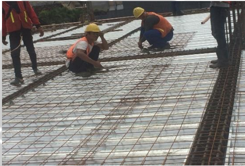
14. Pemasangan Wiremesh Pelat Bondek
