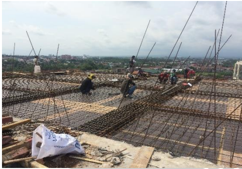
6. Pemasangan Tulangan Atas
