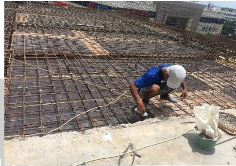
7. Perkuatan Pelat Lantai
