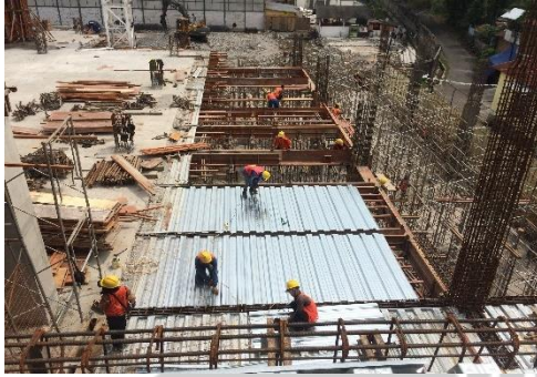
12. Pemasangan Hollow Pelat Bondek
