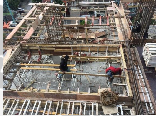
2. Pemasangan Hollow Pada Pelat Konvensional
