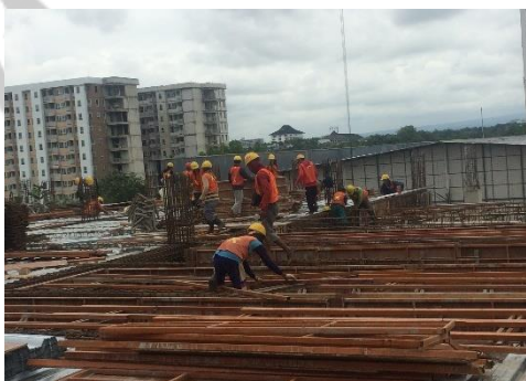
10. Pemasangan Hollow Pelat Bondek
