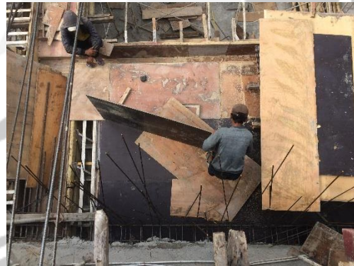
4. Pemasangan Papan Plywood
