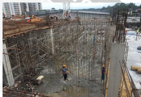
9. Pemasangan Scaffolding Bondek
