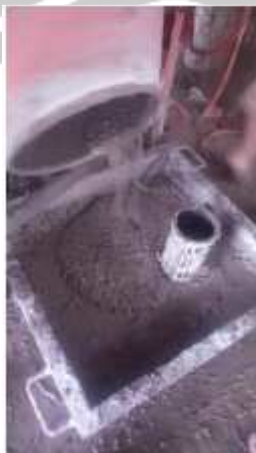
Penuangan Adukan Beton
