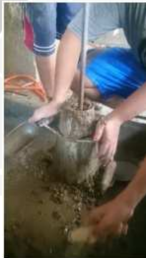
Pengujian Slump Beton
