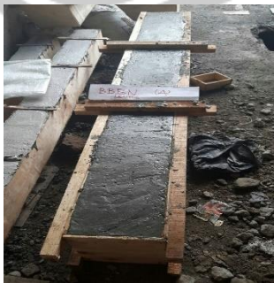
Beton yang sudah dituang ke bekisting
