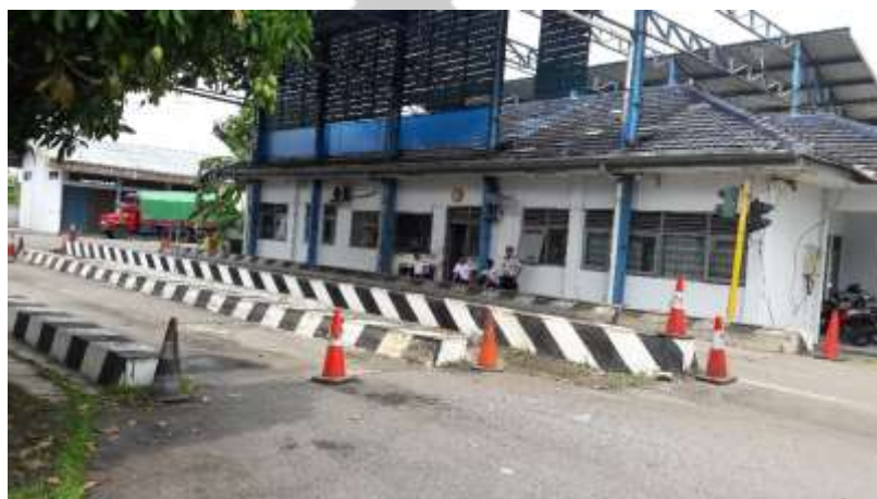
Gambar Lampiran 5-3 Jembatan Timbang Kulwaru
