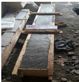
Beton yang sudah dituang ke bekisting
