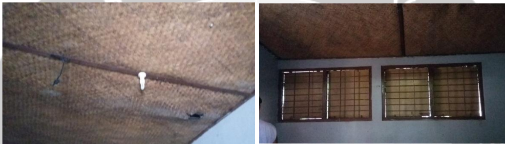
Bagian Plafon dan Ventilasi Kantor
