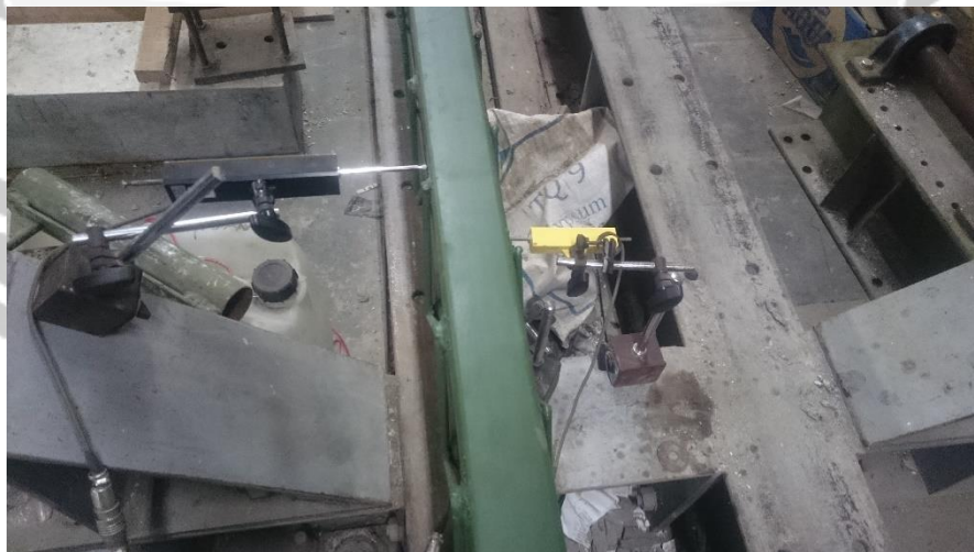
Pemasangan Dial Gauge
