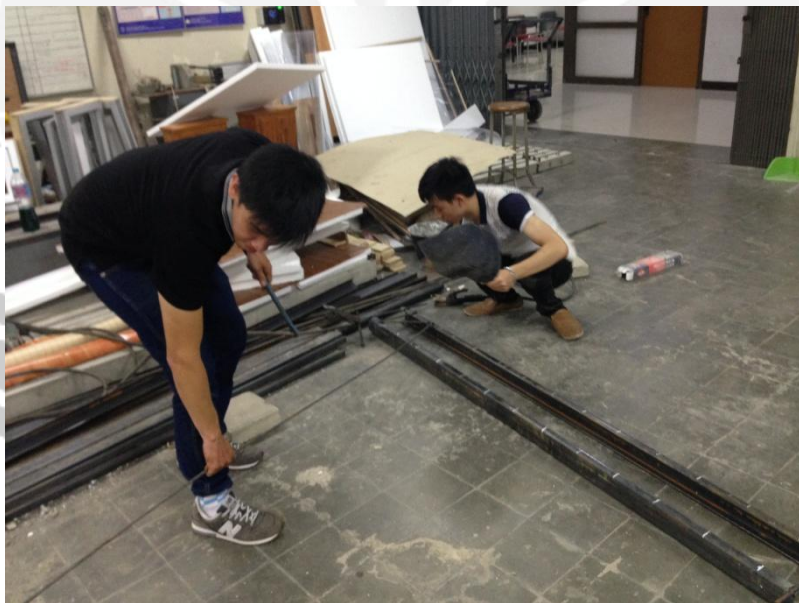
Proses pembengkokkan tulangan
