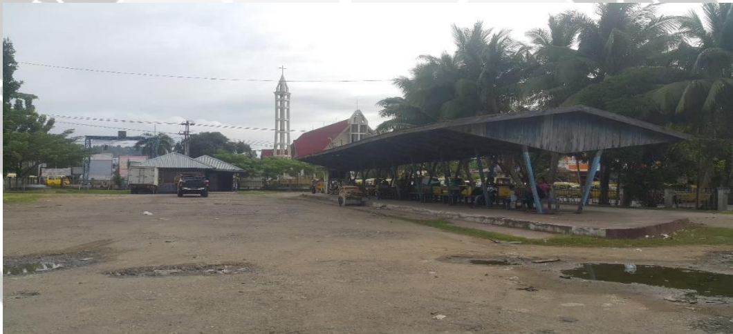
Gambar 5.1. Terminal Penumpang Di Kota Sorong
