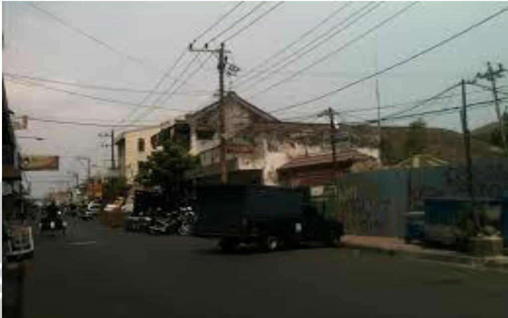
Lampiran Gambar 2: Bangunan Tjan Bian Thiong yang sudah rata dengan tanah.
