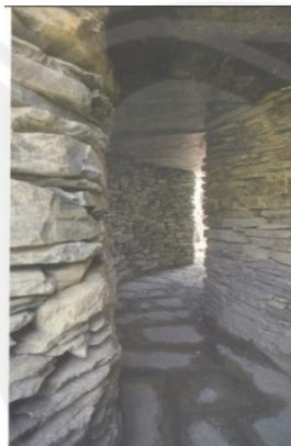
Gambar 65. Konstruksi dinding batu alam
