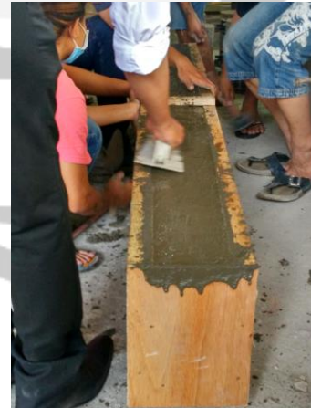
Proses Penuangan Adukan Beton
