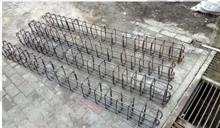
Persiapan Tulangan Balok
