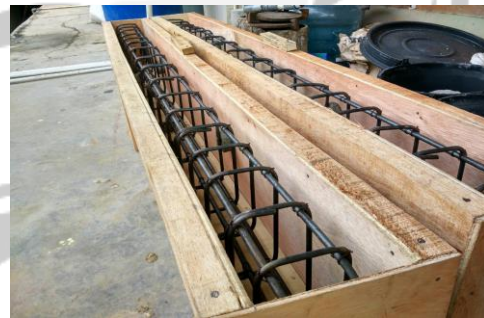
Tulangan Pada Bekisting Balok
