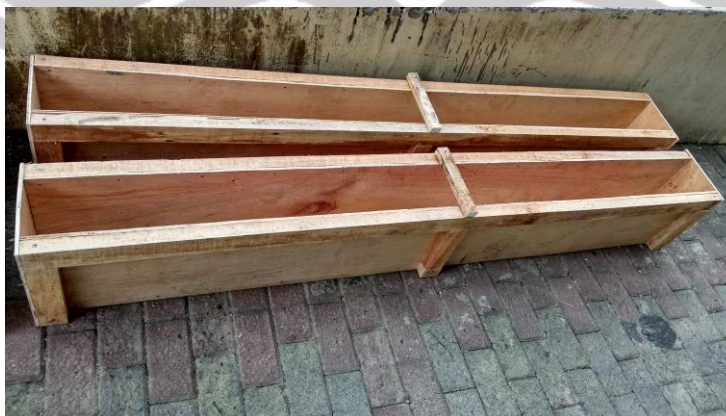
Persiapan Bekisting Balok
