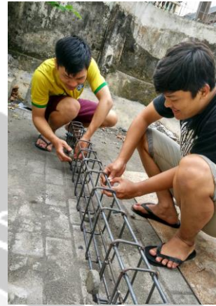
Pemasangan Tahu Beton ( Decking )
