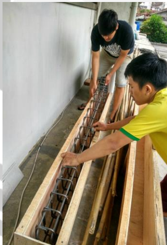
Pemasangan Tulangan Pada Bekisting
