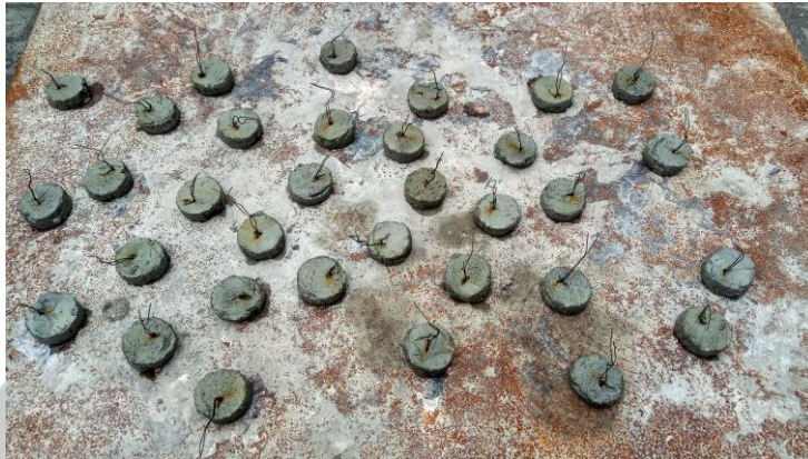
Persiapan Tahu Beton ( Decking ) yang Akan Digunakan pada Tulangan
