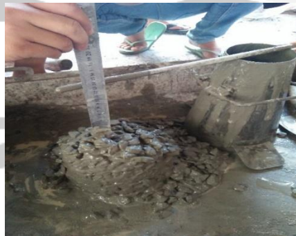
Gambar 4.21 Proses Pengujian Slump
