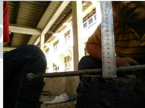
Pengujian Slump Beton Segar
