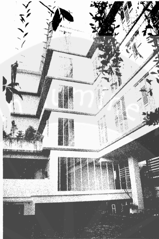
Tampilan Dalam Bangunan HDFS
