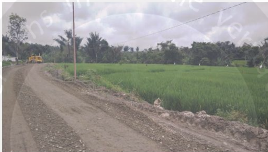
Proyek pembangunan jalan yang akan dikerjakan selama 150 hari.
