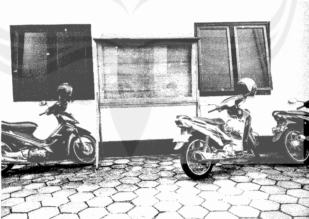
Gambar Papan Pengumuman yang sudah tidak digunakan
