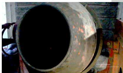
Mixing dengan concrete mixer
