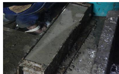
Beton segar di cetakan balok
