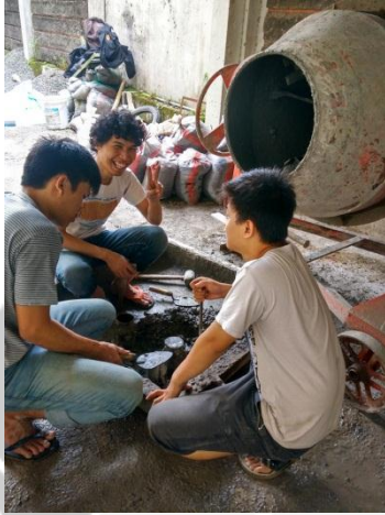
Penuangan Adukan Beton
