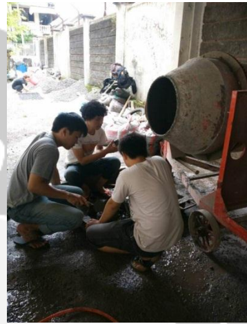
Penuangan Adukan Beton
