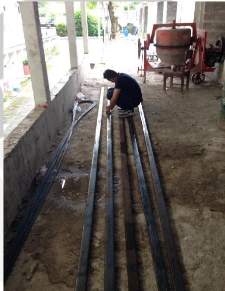
Proses marking profil C sesuai panjang benda uji yang dibutuhkan
