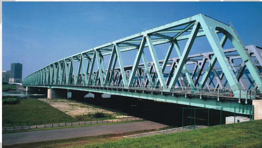
Gambar 2.5. Ilustrasi Jembatan Rangka ( Truss Bridge )
