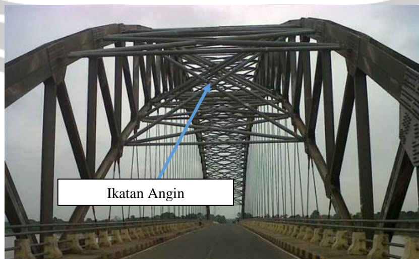
Gambar 2.2. Ikatan Angin pada Jembatan
