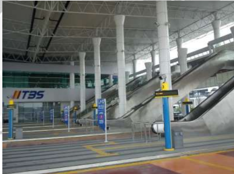
Gambar 2.1. Fasilitas Jalur kedatangan bus Sumber : http://www.tbsbts.com.my
