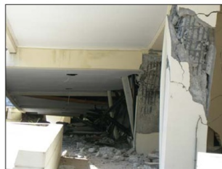
(d) Kolom rusak, tulangan tertekuk, sebagian masih berdiri
