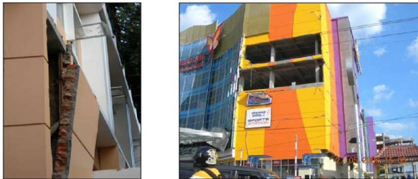
(c) Tembok lepas di kampus UIN (d) Tembok lepas pada Sapphire Square
