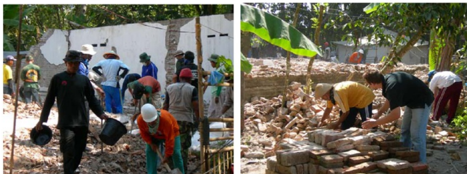
Gambar 6. Pembuangan reruntuhan bangunan dan pemilihan bagian yang dapat dipakai kembali
