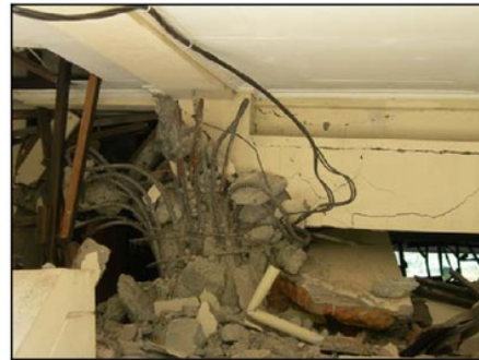
(b) Sebagian kolom runtuh dan tulangan tertekuk
