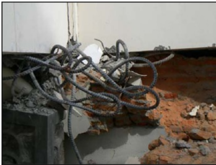
(b) Sebagian kolom runtuh dan tulangan tertekuk
