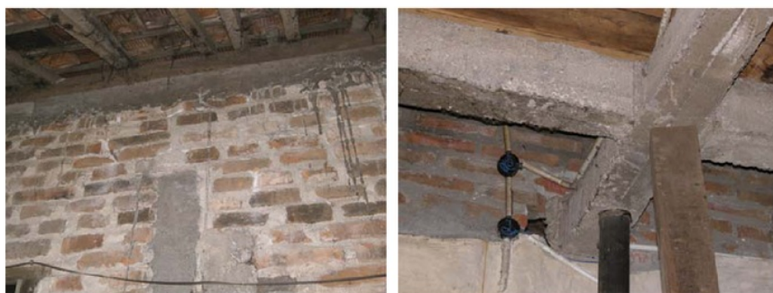
Gambar 3. Balok keliling dan kolom yang tidak saling bertemu
