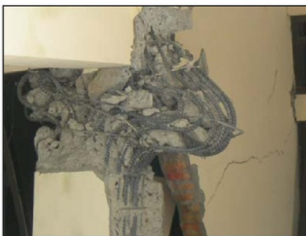
(d) Kolom rusak, tulangan tertekuk, sebagian masih berdiri
