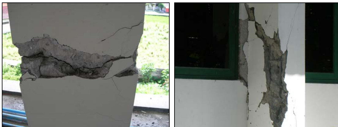
(b) Kolom rusak 2
