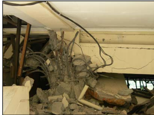
(b) Sebagian kolom runtuh dan tulangan tertekuk
