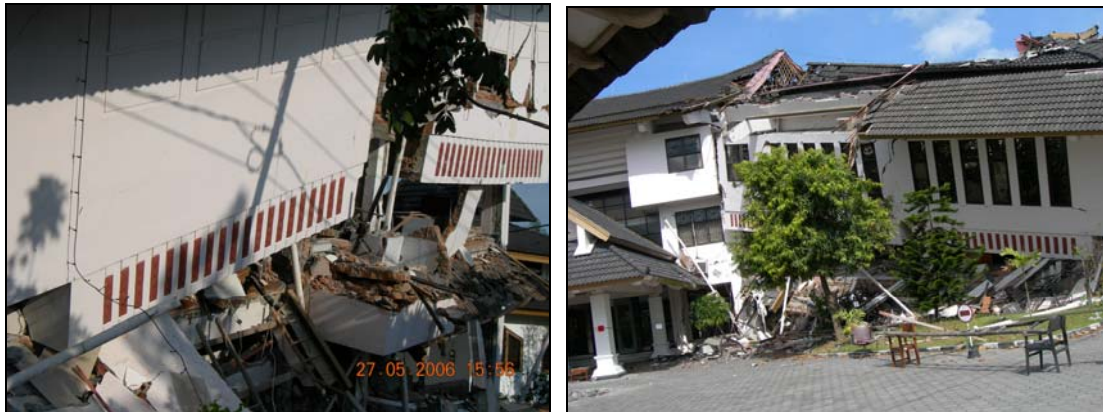
(b) Gedung BPKP runtuh view 3-4
