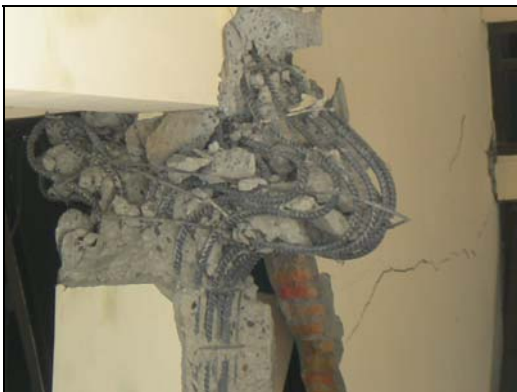
(d) Kolom rusak, tulangan tertekuk, sebagian masih berdiri
