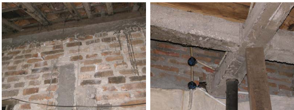
Gambar 3. Balok keliling dan kolom yang tidak saling bertemu
