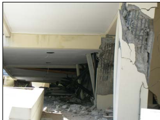
(d) Kolom rusak, tulangan tertekuk, sebagian masih berdiri
