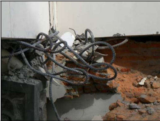
(b) Sebagian kolom runtuh dan tulangan tertekuk
