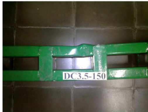
Gambar 3. Kegagalan kolom langsing tanpa pengisi beton ringan
