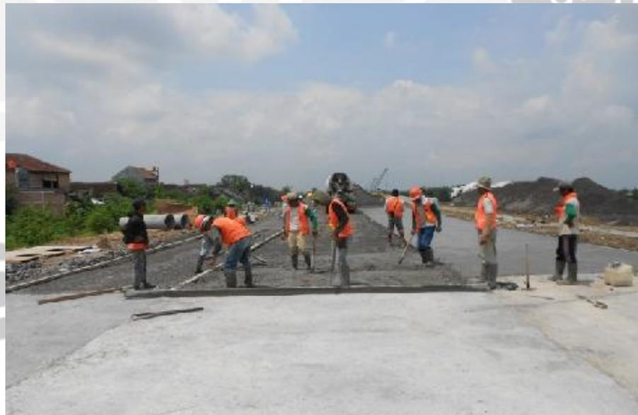
Gambar 2.3 Pekerjaan *lean concrete*
