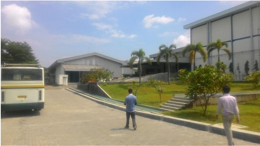
Gambar 4.3.6 – Tim IT saat selesai maintenance Gudang GOJ
