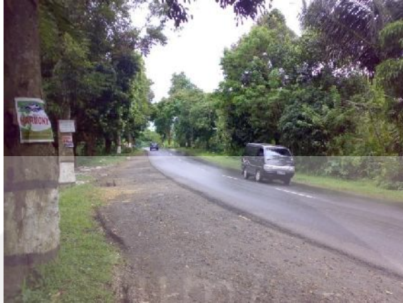
Kondisi Bahu Jalan
