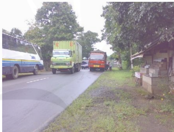
Kondisi Jalan Km 17
