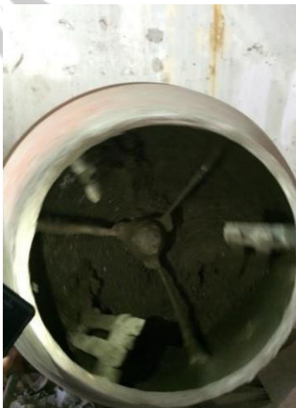
Pengadukan dengan Concrete Mixer
