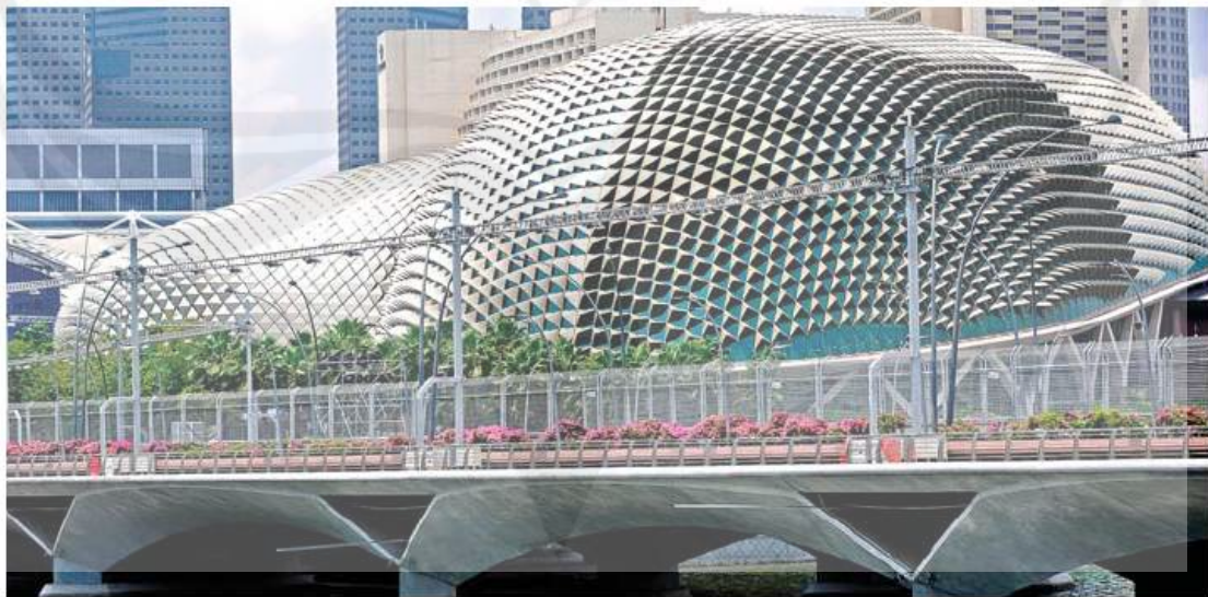
Gambar II.4 Gedung Esplanade Singapura
